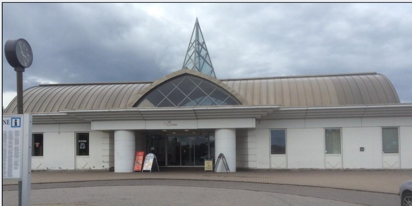
Korsør station og depot. Meget symbolsk hænger der truende skyer over depotet — Foto: Dan Nielsen
